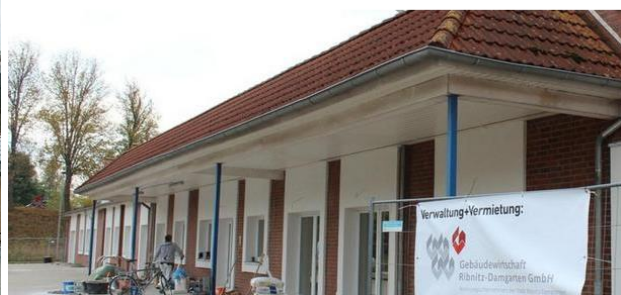
nach dem Umbau (kurz vor Fertigstellung)
