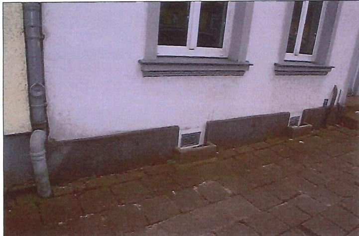
Abbildung 16: dicht verschlossene Kelleröffnungen im Gebäude Bahnhofstraße 1
